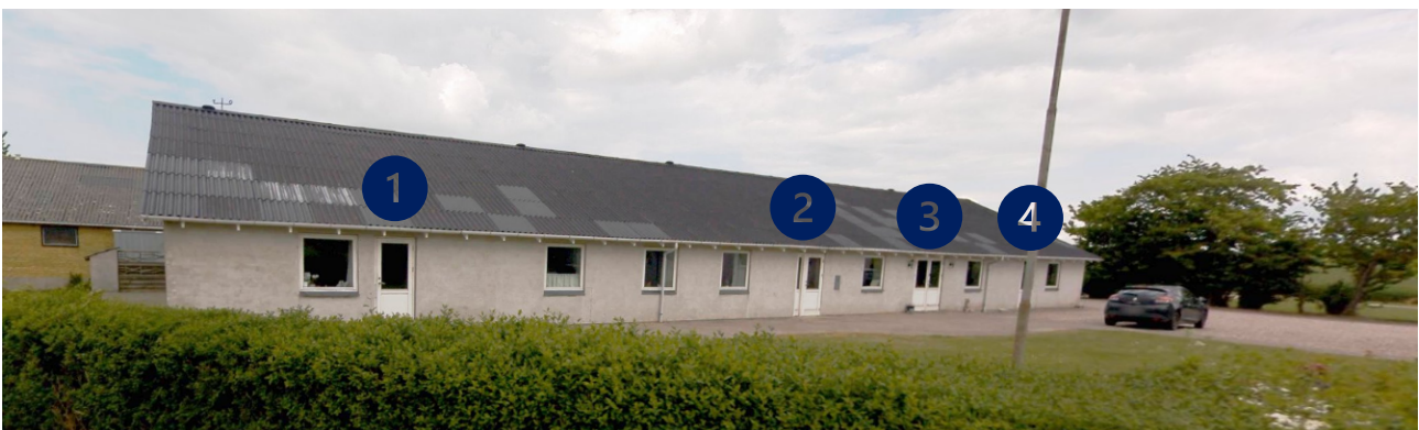
2 - Billede af driftsbygningen, april 2024.
