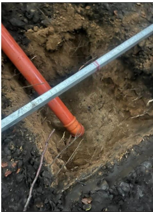
Figur 2 Testopstilling, med rør til tilsætning af vand, og ret-skinne til ophængning af vandstandslogger og vandstandslogger.
