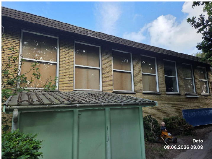
Vinduer på bagside af bygning
