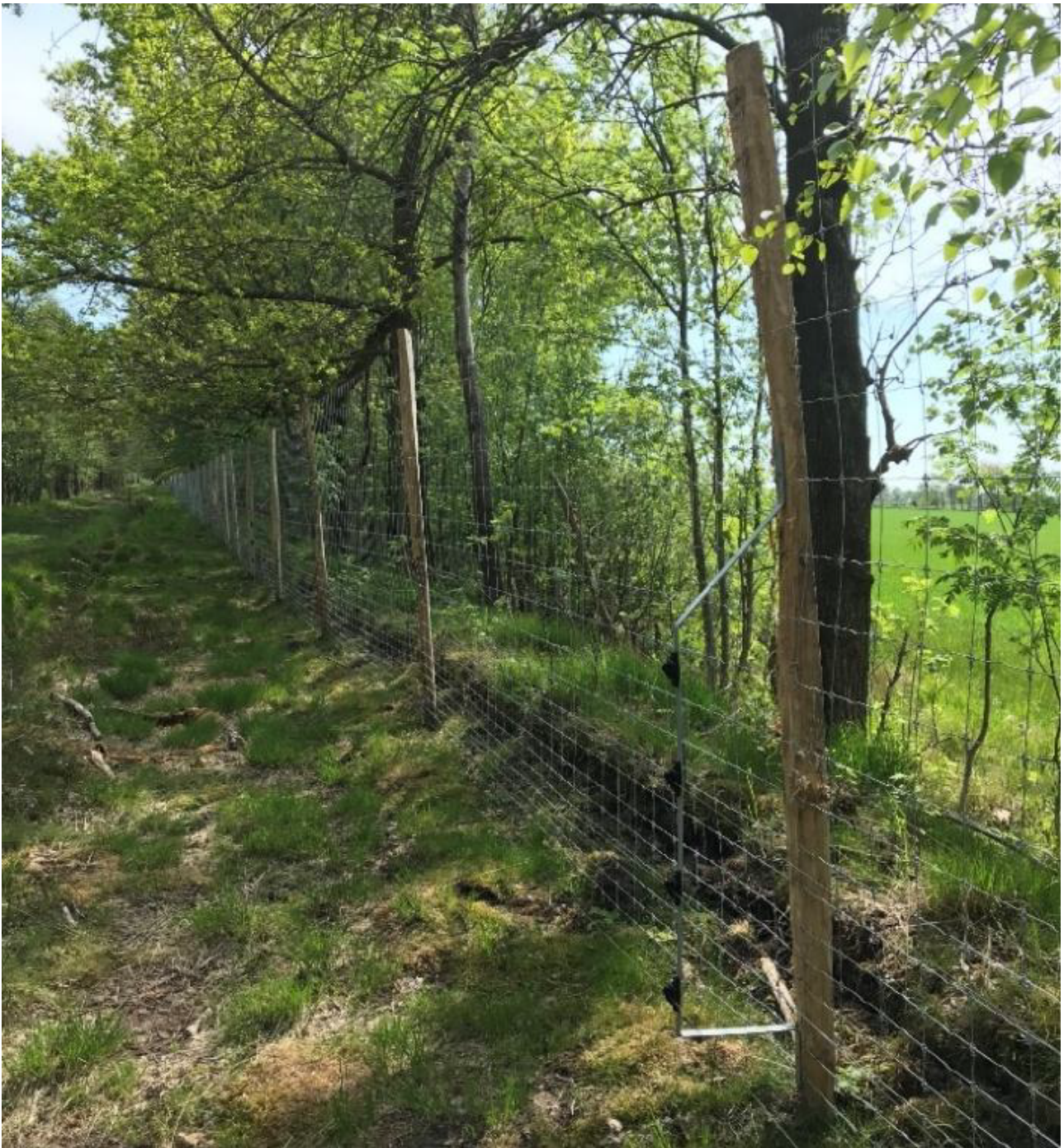
3 – Eksempel på hegnstype: 2,5 m højt vildthege med 4 elektriske tråde monteret på robiniestolper i Lille Vildmose. I Katstrup Vildnis (delområde 2) bliver heget 2,2 m højt.
